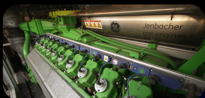
Центральный Мощность: 19 МВт
